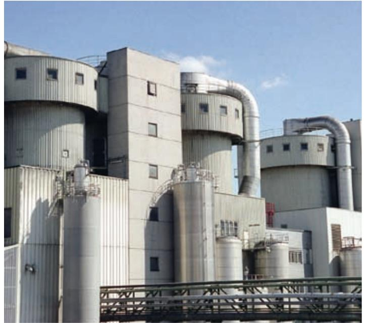
(Bild 2) Sprühtrockentürme für Dispersionspulver im WACKER-
