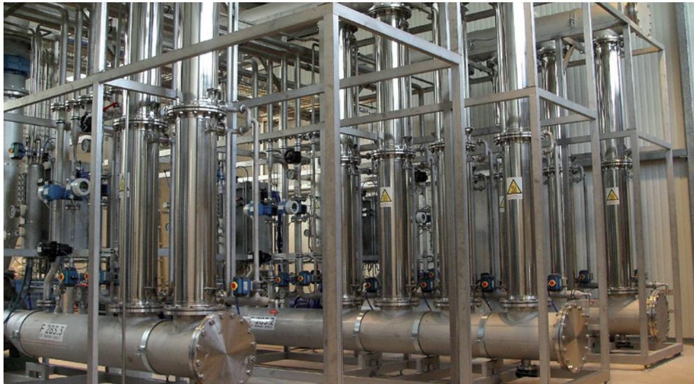
Die Ultrafiltrationsanlage „PVClean“ im Knapsacker S-Betrieb
